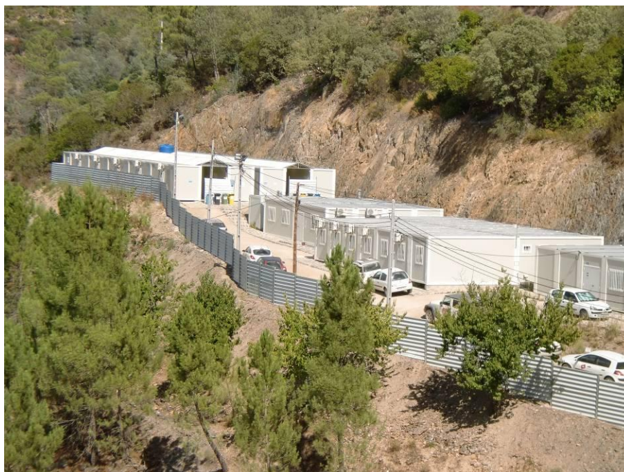
Estaleiro Social - Vista Geral do Estaleiro
