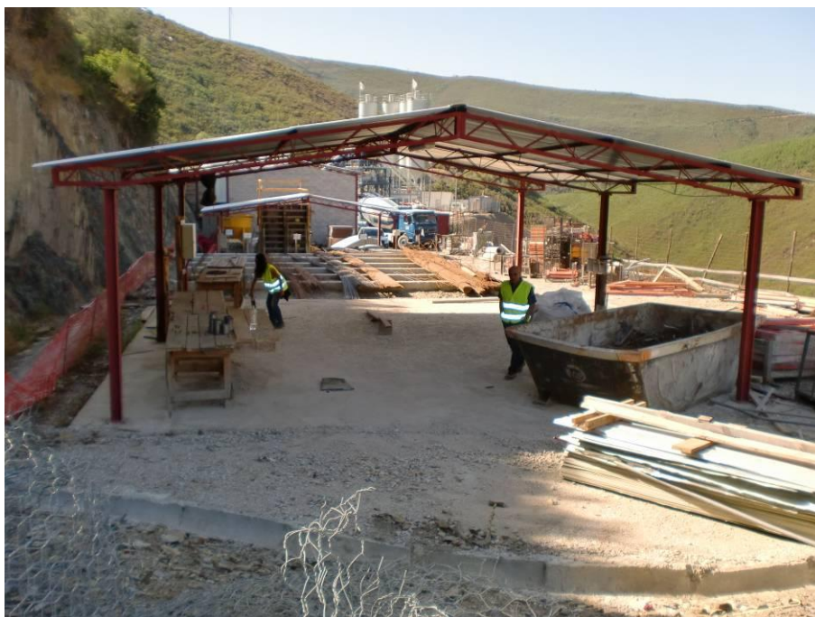
Estaleiro Industrial - Plataforma da Oficina de Cofragens e Carpintaria
