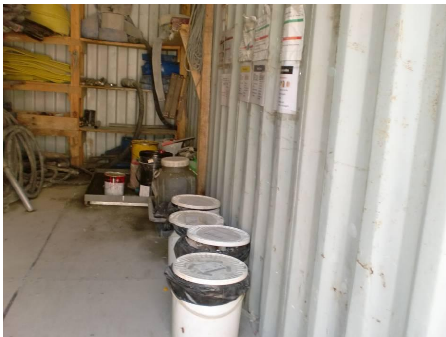
Ecoponto Frente de Obra
