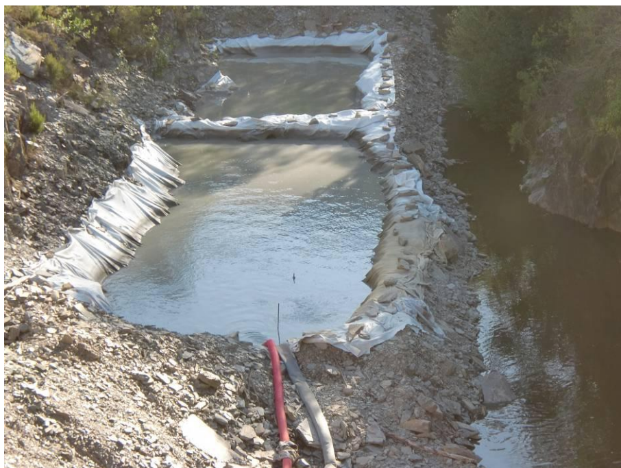
Bacias de Decantação - Frente de Obra
