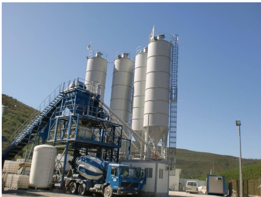
Filtros Partículas - Silos Cimento e Cinzas
