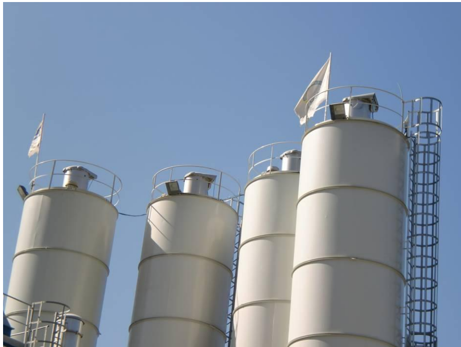
Filtros Partículas - Silos Cimento e Cinzas
