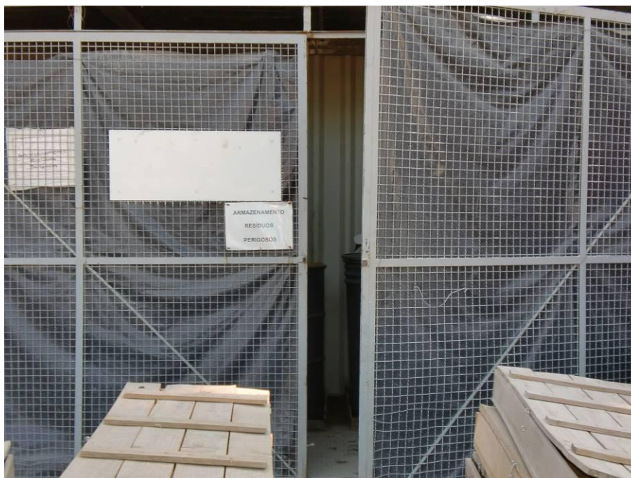
Contentores de Armazename nto Resíduos Perigosos
