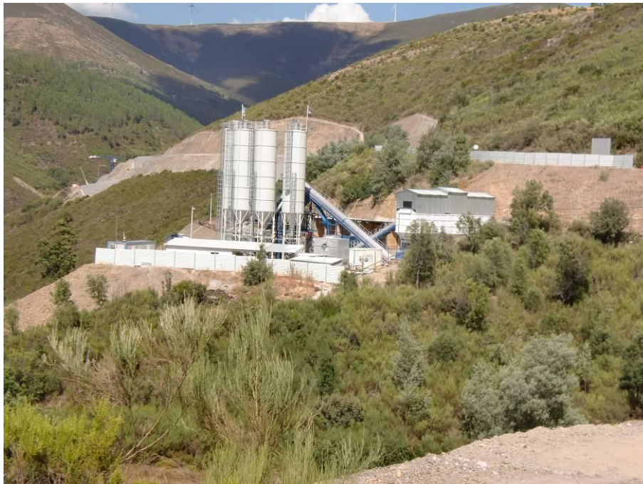
Estaleiro Industrial - Colocação de Vedação
