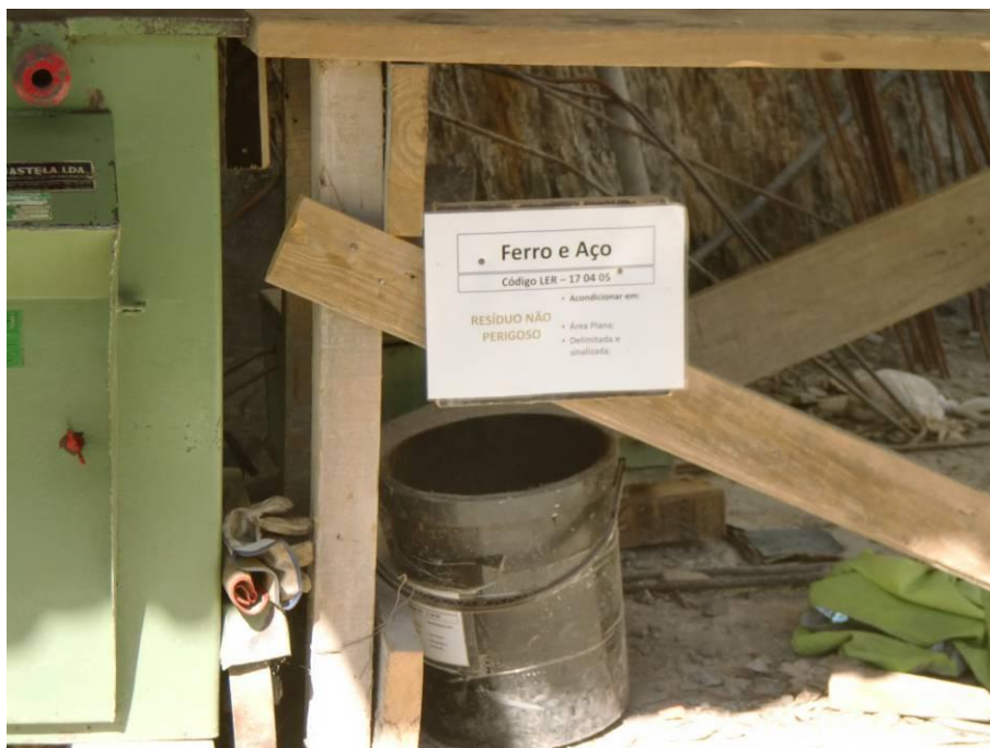
Recipientes de Resíduos nas frentes de obra
