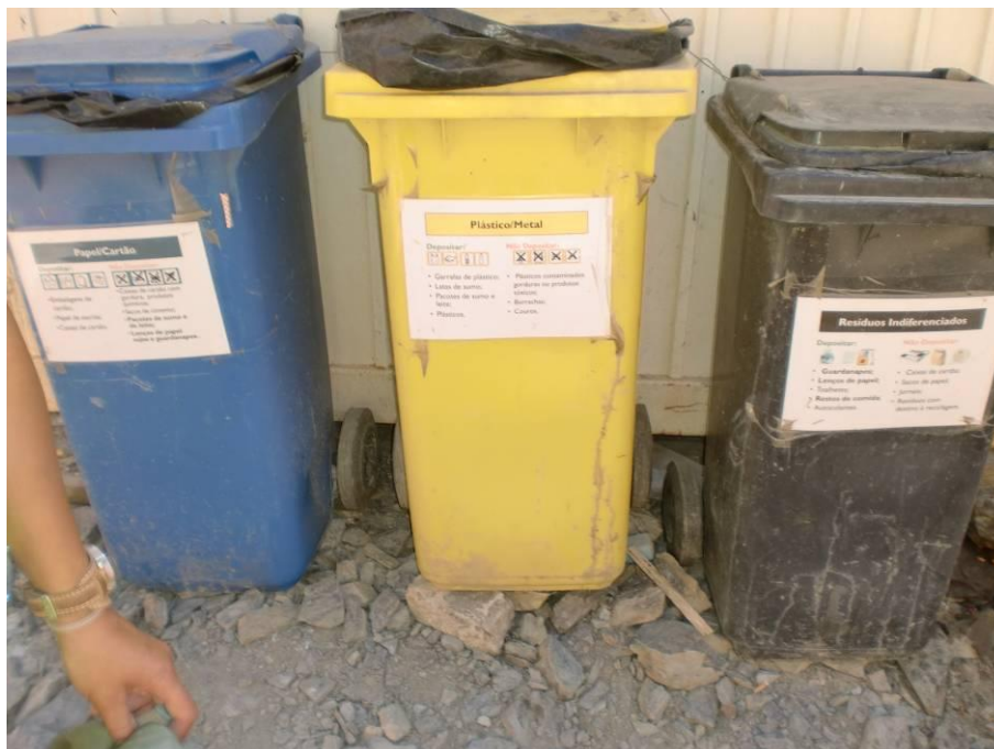
Ecoponto Frente de Obra
