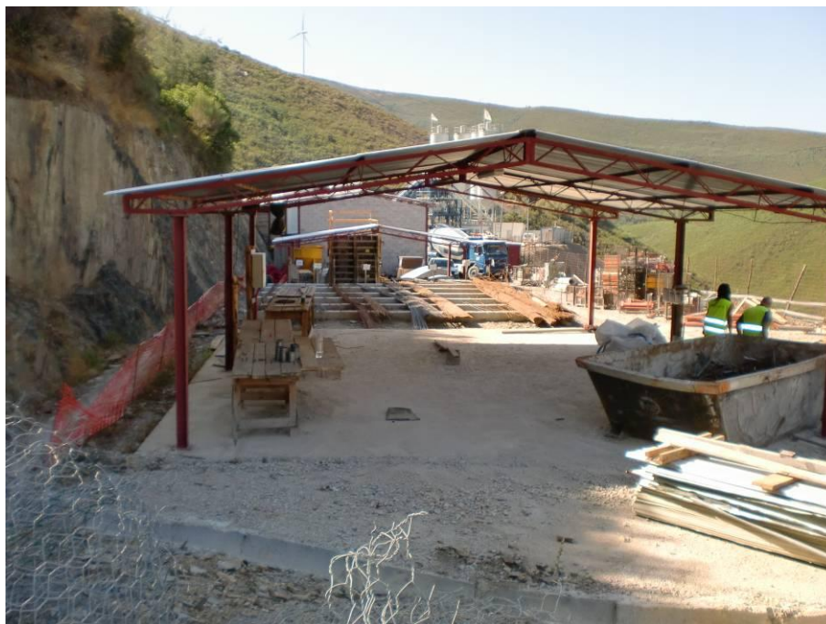
Estaleiro Industrial - Vista Geral do Estaleiro
